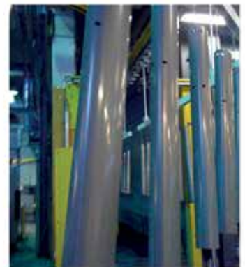
Sproei-installatie met ijzerfosfatering
